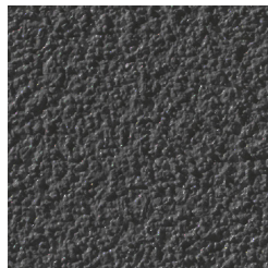
Vollwärmeschutz, Verputz Farbe Schwarz (Symbolfoto)
